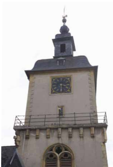
RÉPARATION DE LA COURSIÈRE DU BEFFROI Investissement 2009 : 180 000 €
