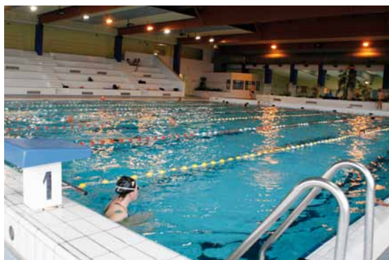
TRAVAUX D'ENTRETIEN DU CENTRE DE LOISIRS NAUTIQUES Investissement 2009 : 210 000 €
