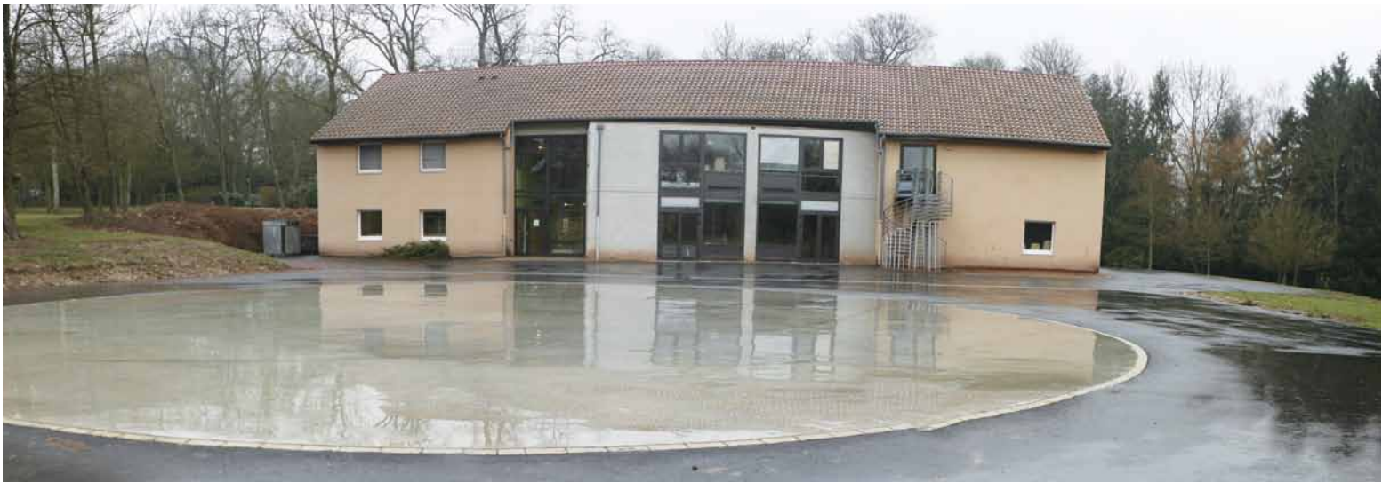
Bâtiment du Centre St-Michel de Volkrange
