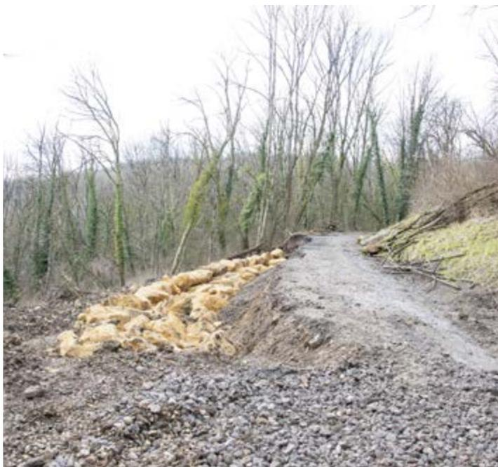
Le 7 janvier 2025 un important glissement de terrain emportant la chaussée sur environ 30 mètres de long, 1 à 3 mètres de large et jusqu'à 3 mètres de profondeur a été constaté sur la voie d'accès au fort de Guentrange après que des travaux d'enfouissement d'un câble souterrain haute tension a eu lieu. L'accès au chemin a été immédiatement fermé et un arrêté de péril a été pris. Une étude géotechnique a été commandée à un bureau d'étude expert par la Ville de Thionville.
