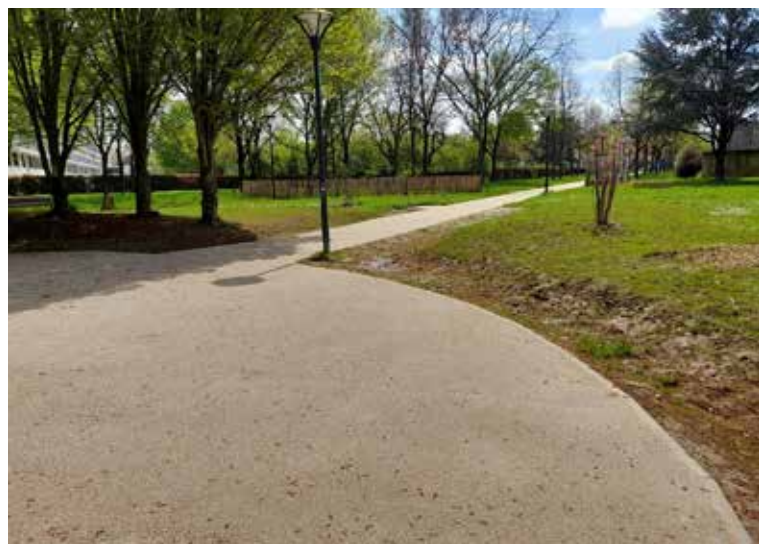
Réfection des allées - Parc Nelson Mandela (tranche 2)
