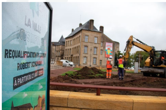
01.09.2025 Travaux de requalification du square Schuman devant l'Hôtel de Ville
